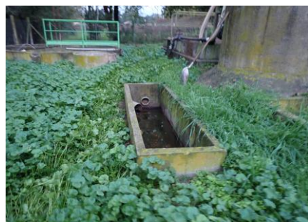
Canal de comptage de sortie
