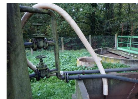
Recirculation / Extraction des boues
